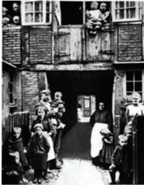
7.7. Cartier muncitoresc din Hamburg pe la 1900; Casele sunt cele construite în evul mediu
